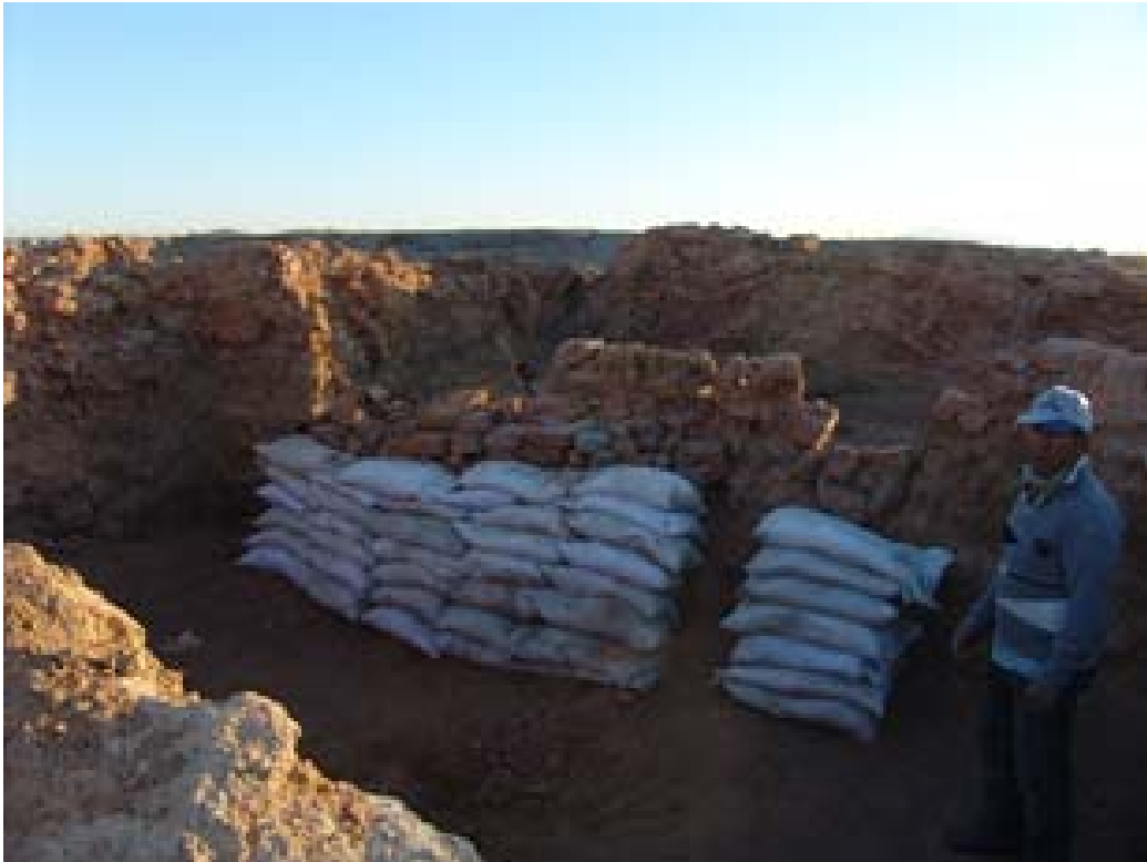
Hizmet Binası' nın zayıf duvarlarının desteklenmesi.
