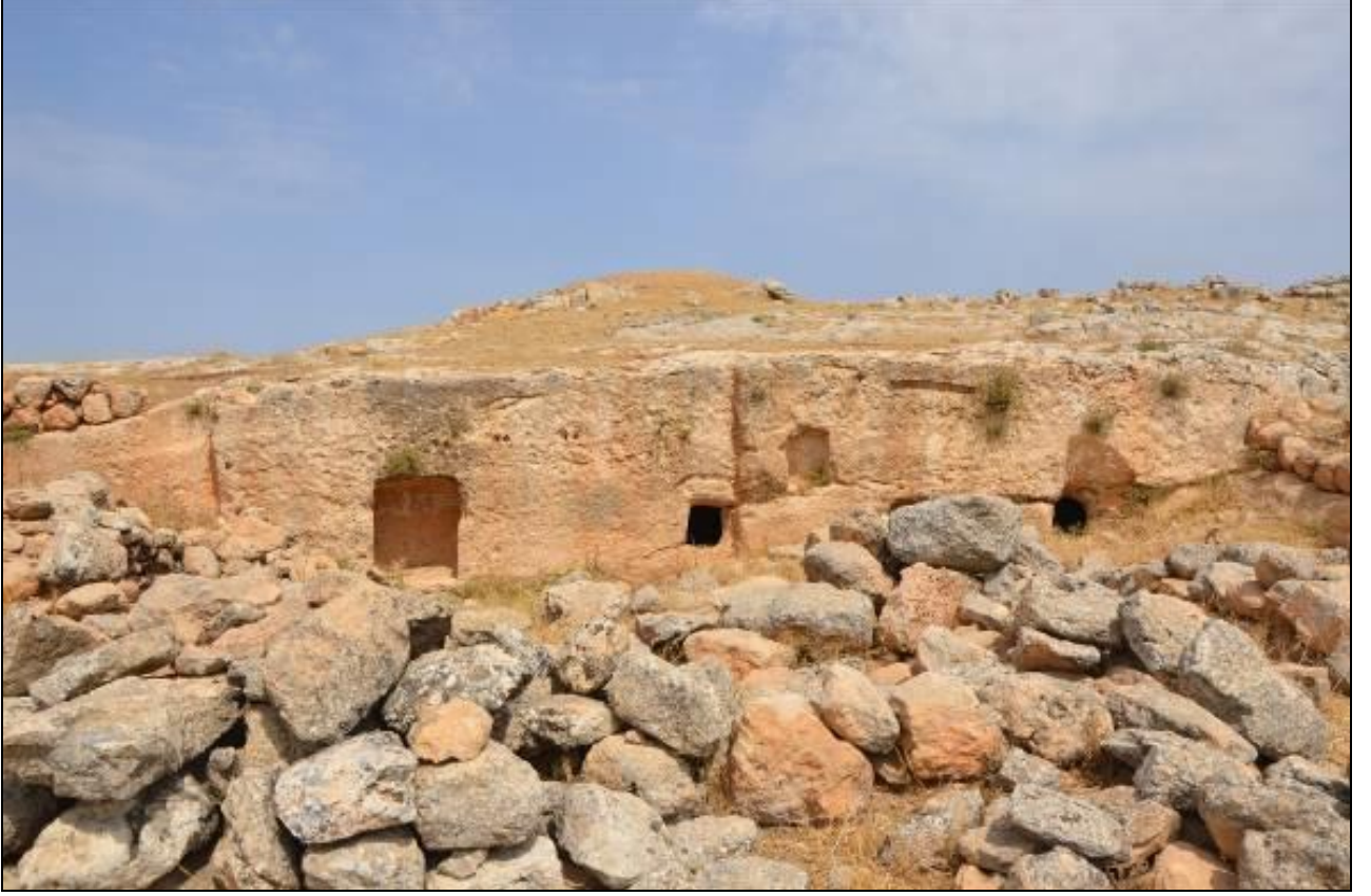
Resim 29. Kargalı Köyü Ahır Yapısı Güneyden Görünüm.
