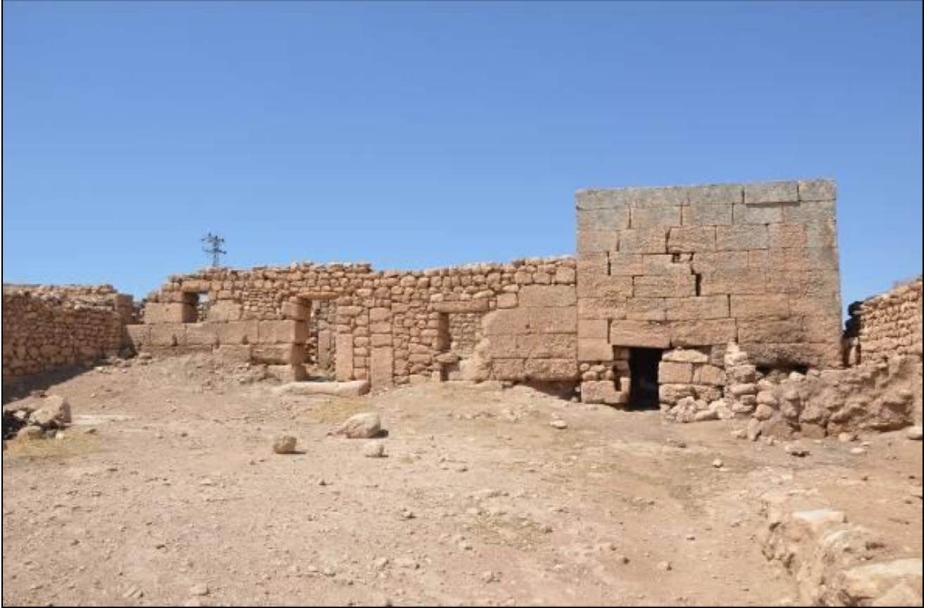
Resim 1: Örenli Köyü Köy içi Yapılarının Güneyden Görünümü.
